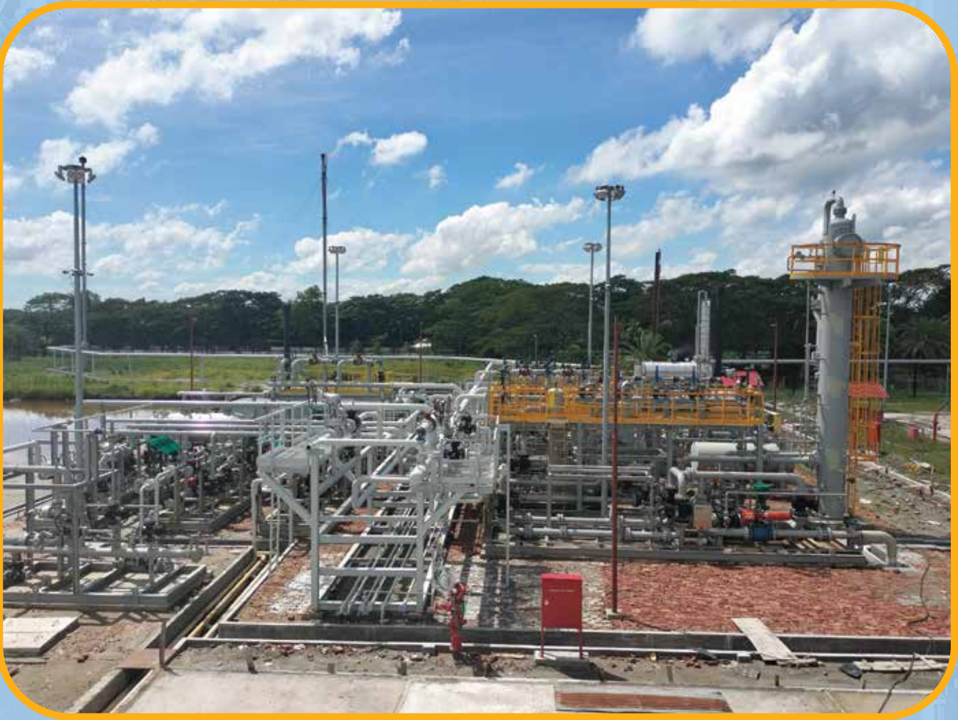
শাহবাজপুর গ্যাসক্ষেত্রে স্থাপিত ৬০ এমএমএসসিএফডি ক্ষমতাসম্পন্ন প্রসেস প্ল্যান্ট
